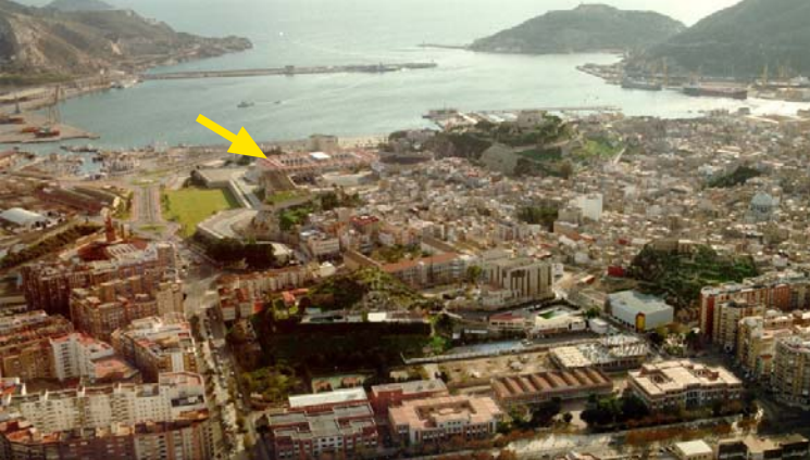
Vista aérea de Cartagena con la situación del Campus Muralla del Mar
